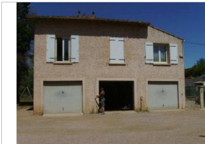
Vue générale - Auteur : EGIS Eau
