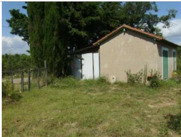
Vue générale - Auteur : EGIS Eau
