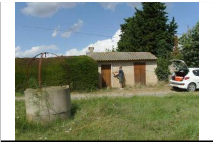
Vue générale - Auteur : EGIS Eau
