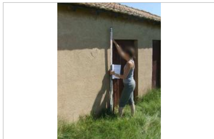
Vue rapprochée - Auteur : EGIS Eau
