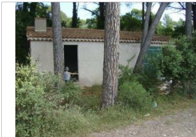
Vue générale - Auteur : EGIS Eau
