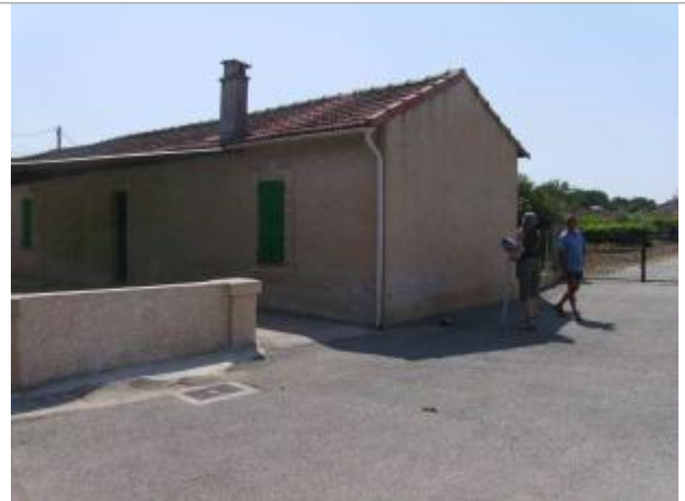
Vue générale - Auteur : EGIS Eau
