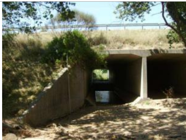
Vue générale - Auteur : EGIS Eau
