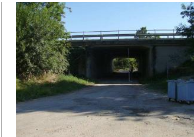
Vue générale - Auteur : EGIS Eau
