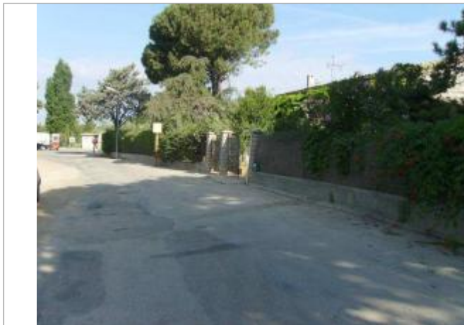
Vue générale - Auteur : EGIS Eau
