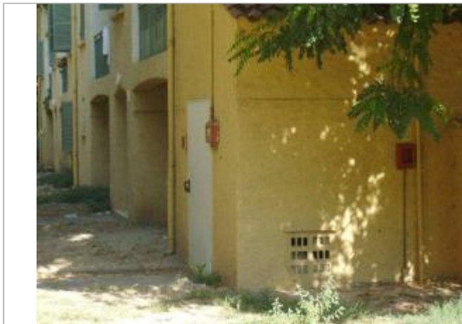
Vue générale - Auteur : EGIS Eau
