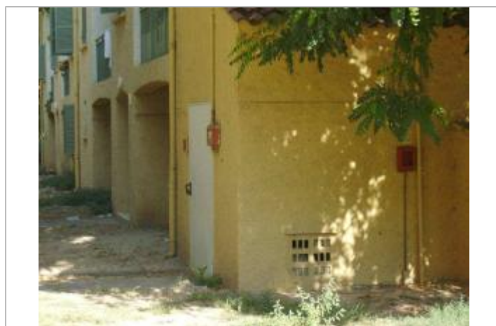
Vue générale - Auteur : EGIS Eau
