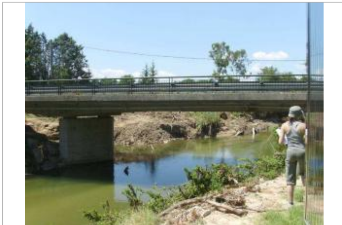
Vue générale - Auteur : EGIS Eau
