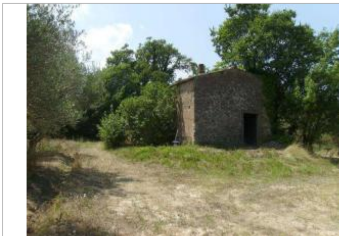
Vue générale - Auteur : EGIS Eau
