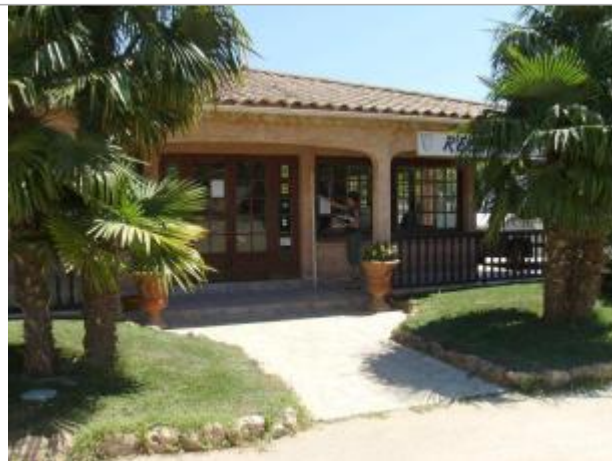
Vue générale - Auteur : EGIS Eau
