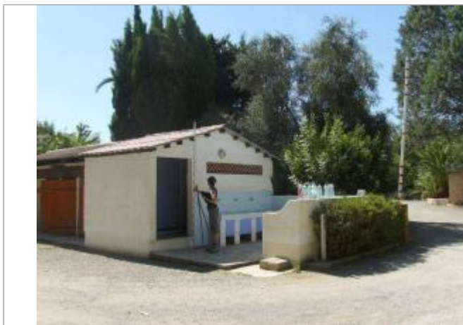
Vue générale - Auteur : EGIS Eau
