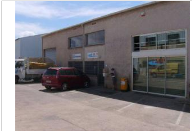
Vue générale - Auteur : EGIS Eau
