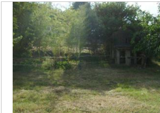
Vue générale - Auteur : EGIS Eau
