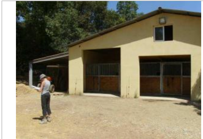
Vue générale - Auteur : EGIS Eau
