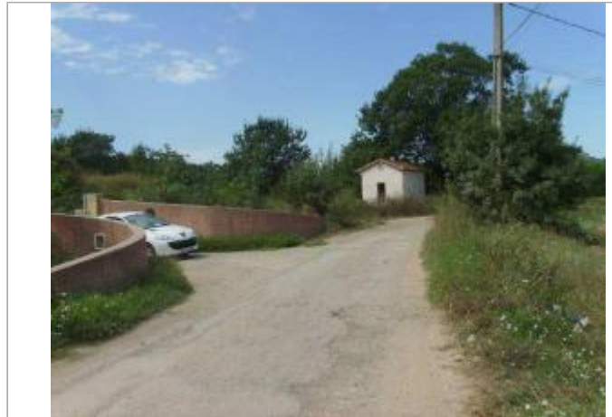
Vue générale - Auteur : EGIS Eau
