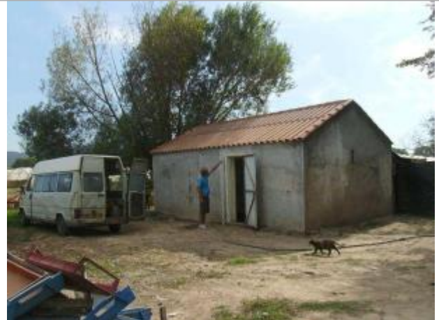
Vue générale - Auteur : EGIS Eau
