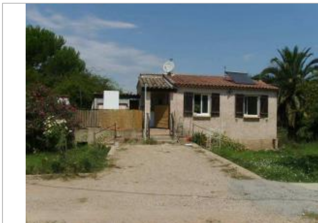
Vue générale - Auteur : EGIS Eau
