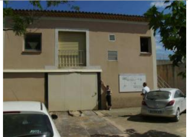
Vue générale - Auteur : EGIS Eau
