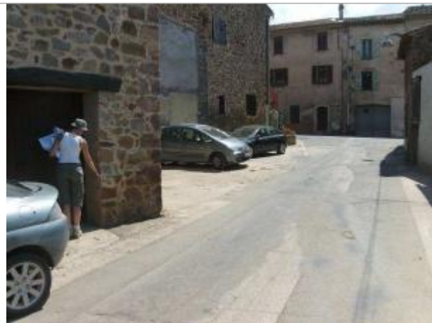
Vue générale - Auteur : EGIS Eau
