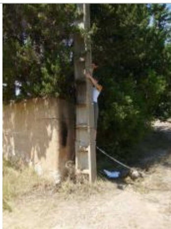
Vue rapprochée - Auteur : EGIS Eau
