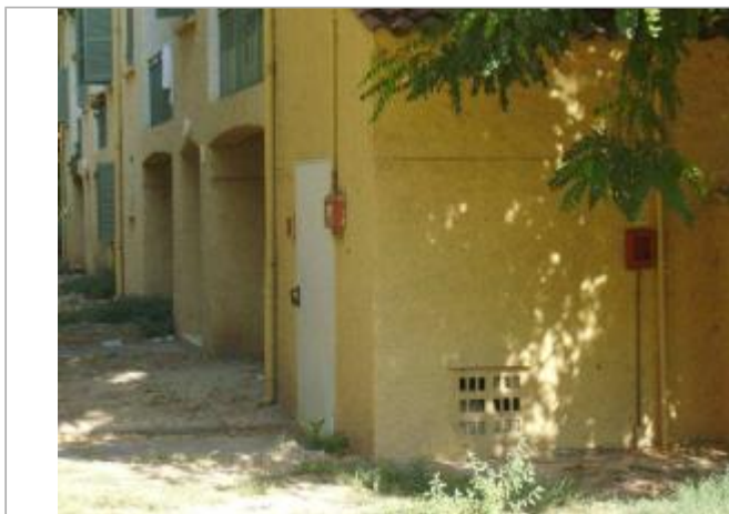
Vue générale - Auteur : EGIS Eau
