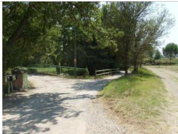
Vue générale - Auteur : EGIS Eau
