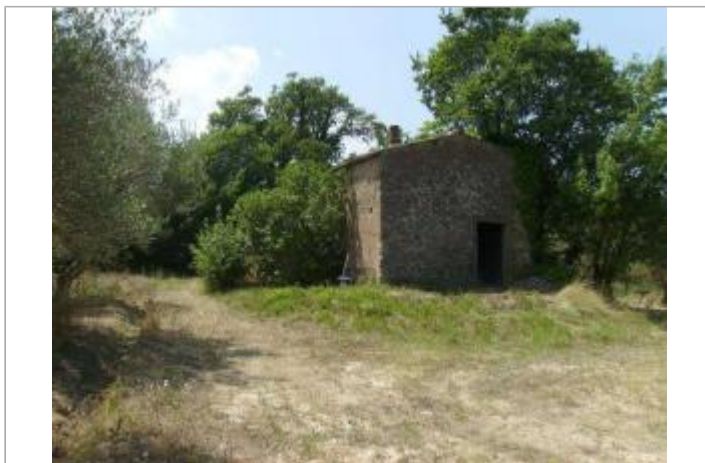
Vue générale - Auteur : EGIS Eau
