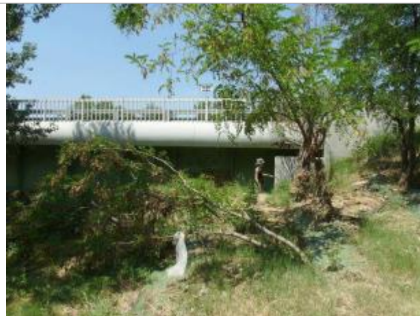
Vue générale - Auteur : EGIS Eau
