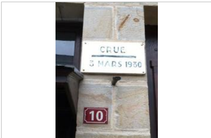
Vue du repère (photo Design Hydraulique)
