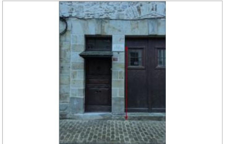
Vue du site (photo Design Hydraulique)
