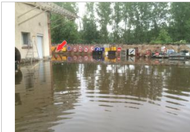
Site pendant la crue de juin 2016 (source : SDEL Berry)
