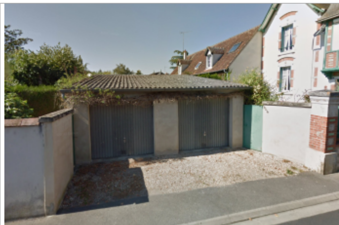
Emplacement du site (source : Google Street View, sept. 2012)
