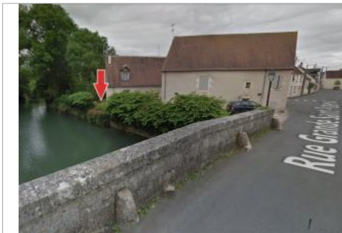
Emplacement du site (source : Google Street View, juil. 2016)
