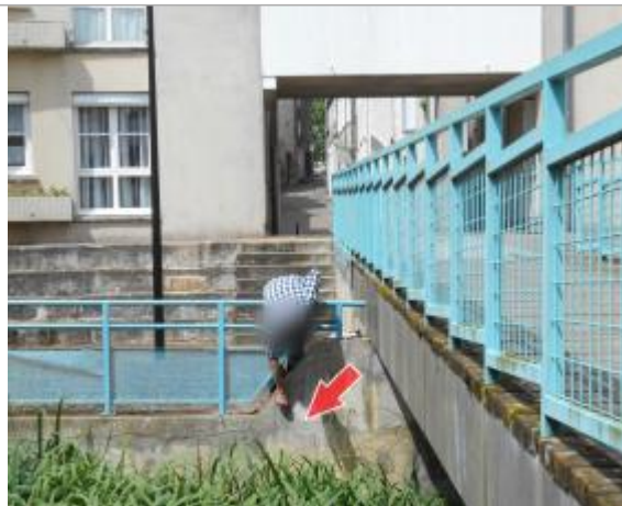
Site et repère de la crue de juin 2016
