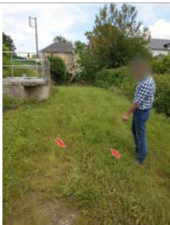
Repère, avant la station de relevage
