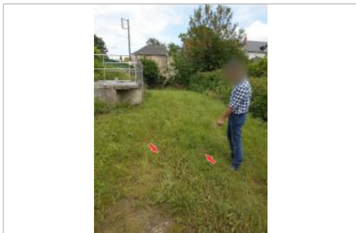
Repère, avant la station de relevage
