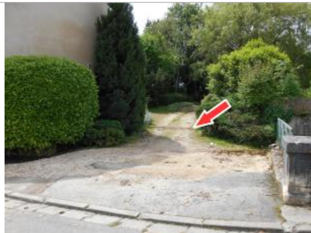
Vue du site et du repère de la crue de juin 2016
