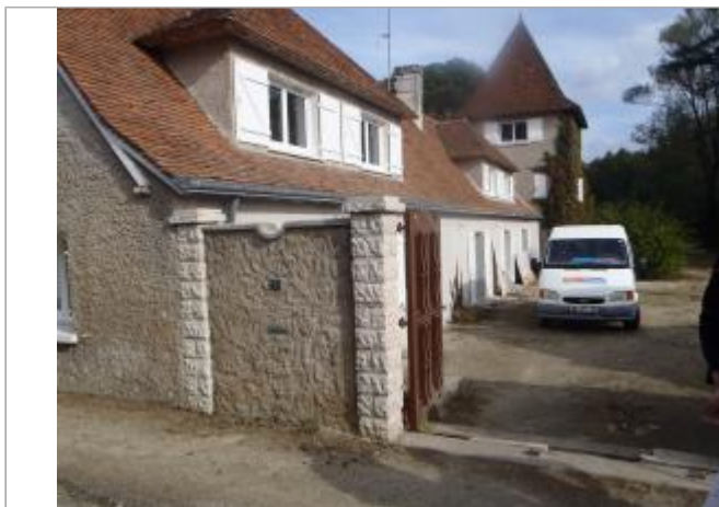
Vue du site
