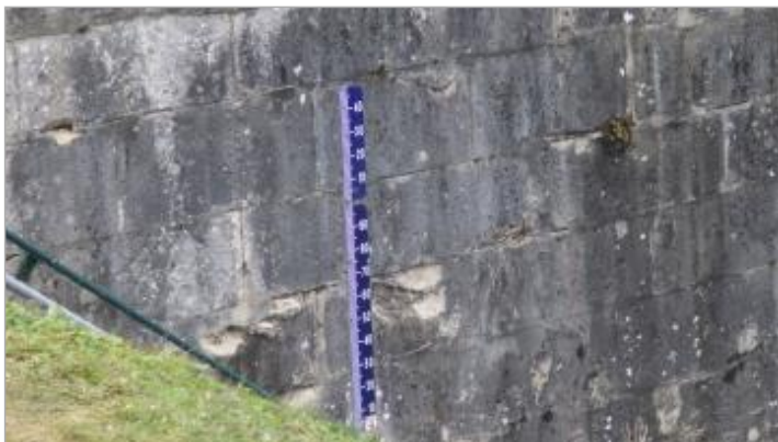
Echelle amont de l'écluse de Vauxrot
