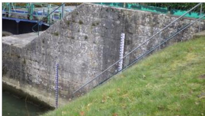
Echelle aval de l'écluse de Soissons Vauxrot
