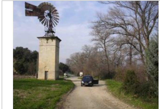
Vue du site
