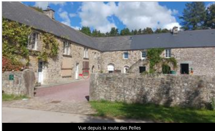
Vue depuis la route des Pelles
