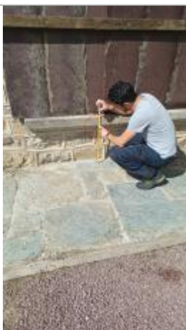
Laisse de crue à 47 cm/sol.
