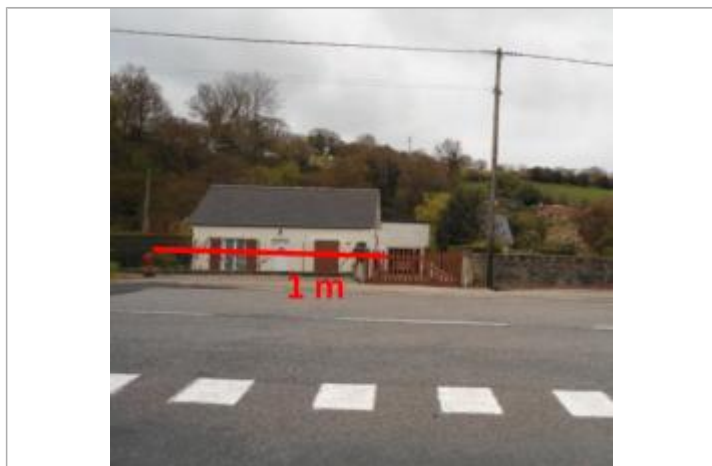
En aval immédiat du Pont Cosnard (photo CPL)
