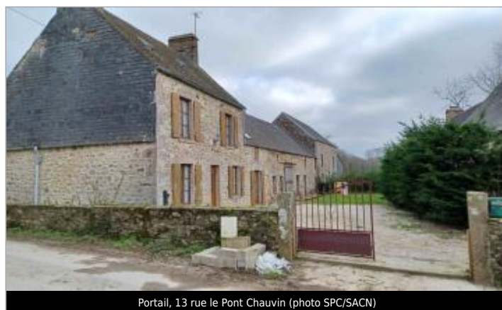
Portail, 13 rue le Pont Chauvin (photo SPC/SACN)
