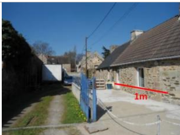
Rue le Pont Chauvin (photo CPL)
