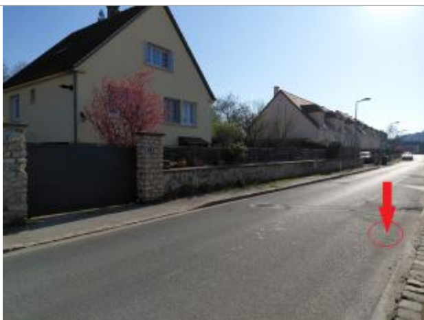
Laisse de crue au sol.
