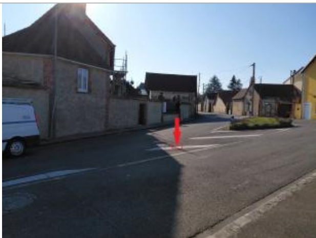
laisse de crue au sol.
