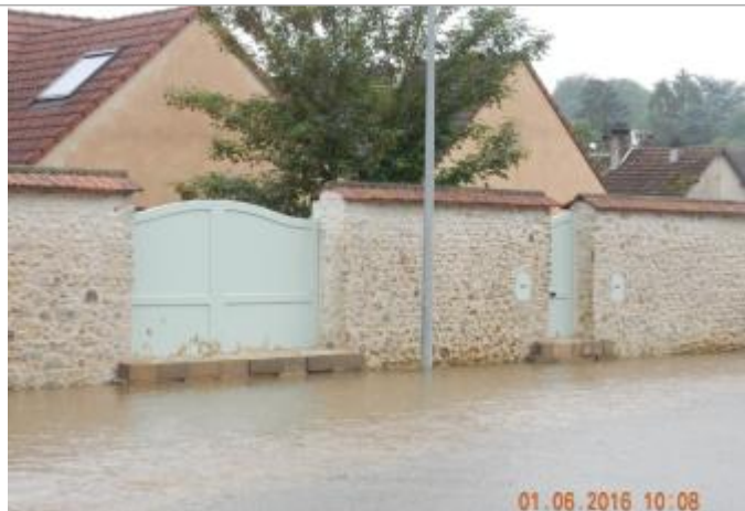
A proximité du transformateur de la Tournachère (photo SPC SACN)
