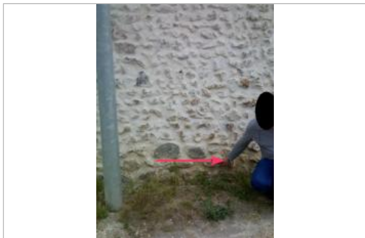
A proximité du transformateur de la Tournachère (photo SPC SACN)
