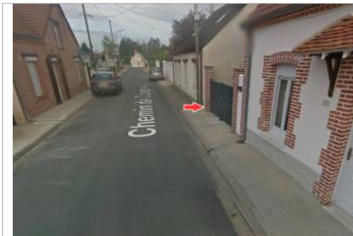
Site et repère de la crue de juin 2016 (source : Google Street View, mai 2013)
