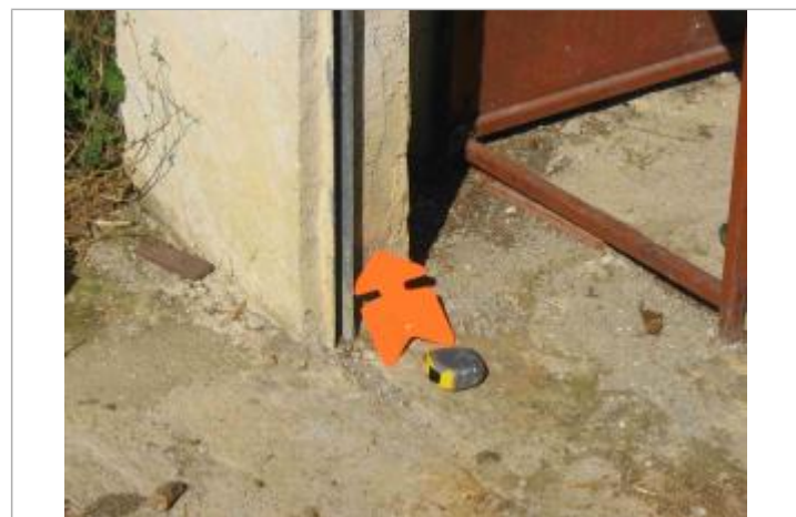
Photo du site - Auteur : Hydrologik Ingénierie
