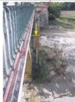
Collias : RD 3, niveau sur pilier du Pont sur le Gardon
